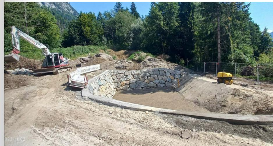
Oberflächenwasser von Teilen des Oberfeldwegs und des Römerwegs zu versickern. Zusammenhängend mit dieser Baumaßnahme werden Teile der öffentlichen Straße im Oberfeldweg neu entwässert. Gleichzeitig wird die bestehende alte Wasserleitung ausgetauscht und vergrößert. Aus Sicherheitsgründen wird die Anlage noch mit einer Absturzsicherung versehen. An den Böschungen wurden einheimische Blumenwiesen ausgesät. Nach Fertigstellung der Restarbeiten werden heimische Sträucher und Bäume gepflanzt.
